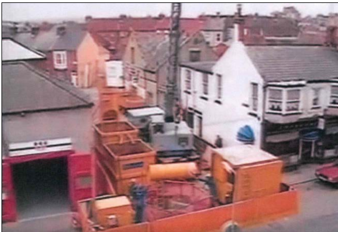
Příklad ZS pro mikrotunelování v reálném, povrchově stísněném prostoru.
